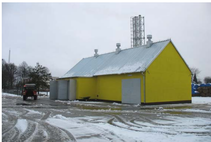
Budynek kotłowni w Polnicy
