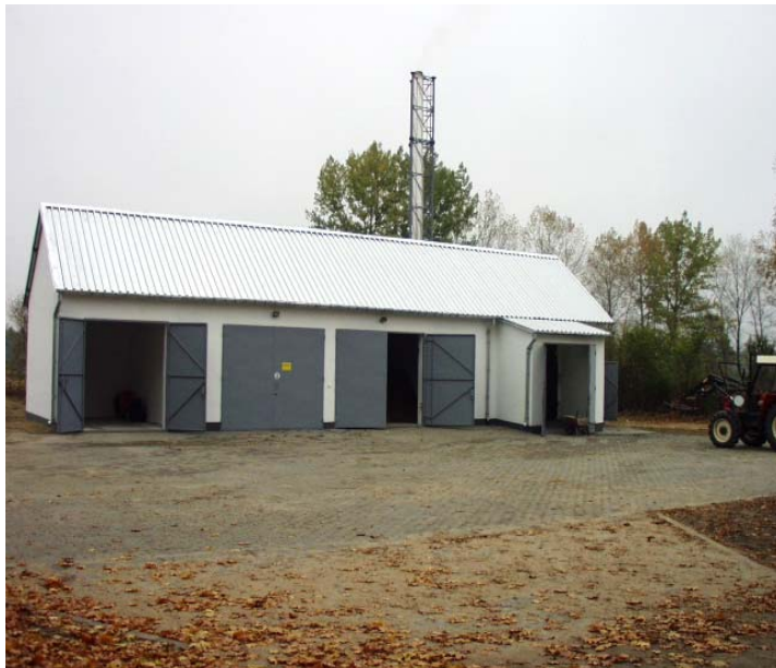
Budynek kotłowni w Wierzchowie Dworcu
